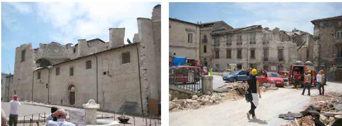
Figura 5.53-5.54 Cúpula derrumbada de la Iglesia de las Almas Santas. Visita del autor en la "zona roja" juntos con el cuerpo de bomberos de L'Aquila. Fotos propias del autor.
