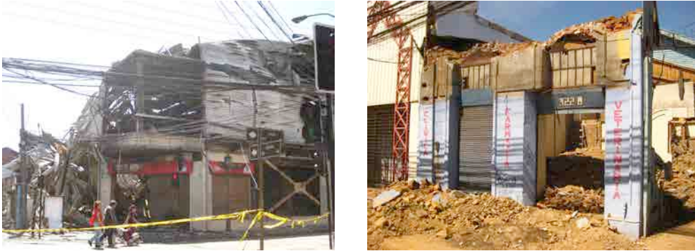
Figura 6.73-6.74 Casas derrumbadas en Talcahuano - Fotos propias del autor.
