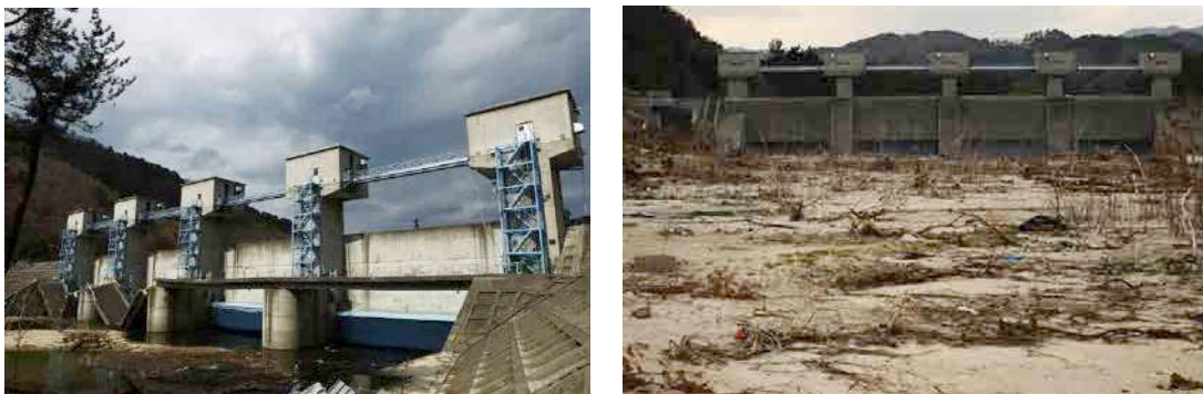
Figura 7.6-7.7 Muro de protección y puerta móvil de Fudai de 15,50 metros de alto y 205 m de ancho. Antes y después del tsunami.
