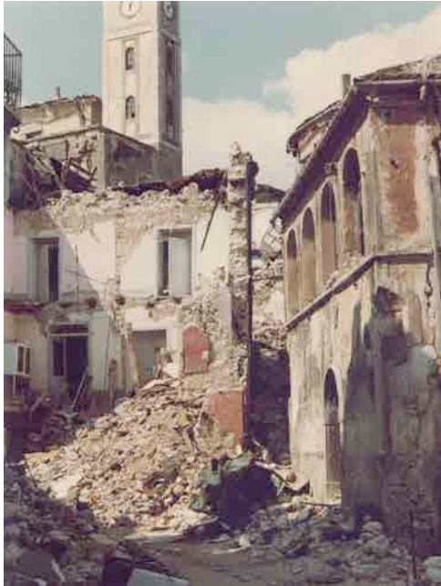
Figura 5.25 Derrumbes en Calabritto.
