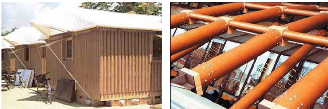
Figura 7.33-7.34 Paper Log Houses. Vista. Figura 43. Paper Log Houses. Vista del detalle de los tubulares.
