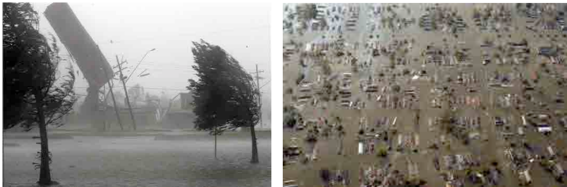
Figura 8.11-8.12 Los fuertes vientos crearon los primeros graves daños a las viviendas e infraestructuras, las líneas telefónicas y eléctrica saltaron no permitiendo o haciendo muy difícil la comunicaciones de evacuación que, mientras tanto, habían sido enviadas. Fuente: http://www.tgcom24.mediaset.it/fotogallery/fotogallery8217.shtml?1
