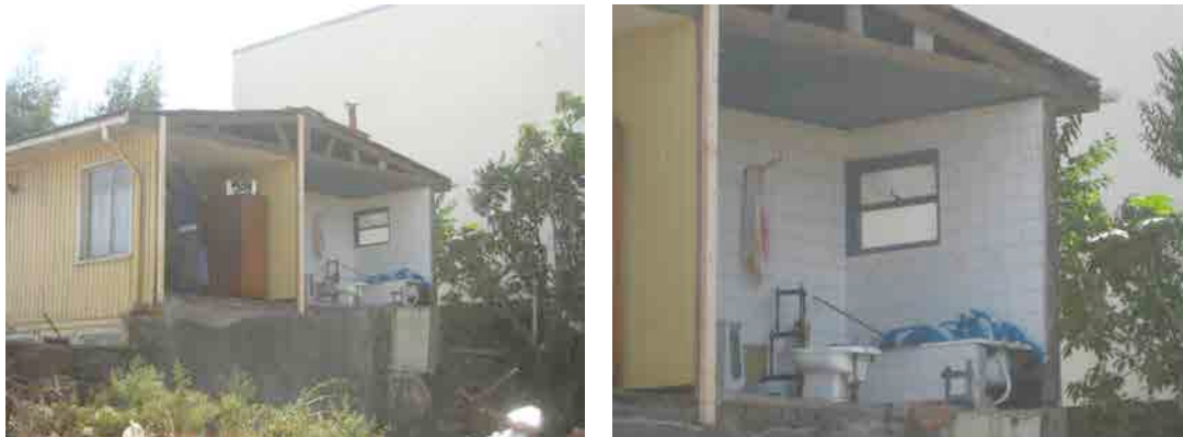
Figura 6.81-6.82 Casas derrumbadas en Dichato - Fotos propias del autor.
