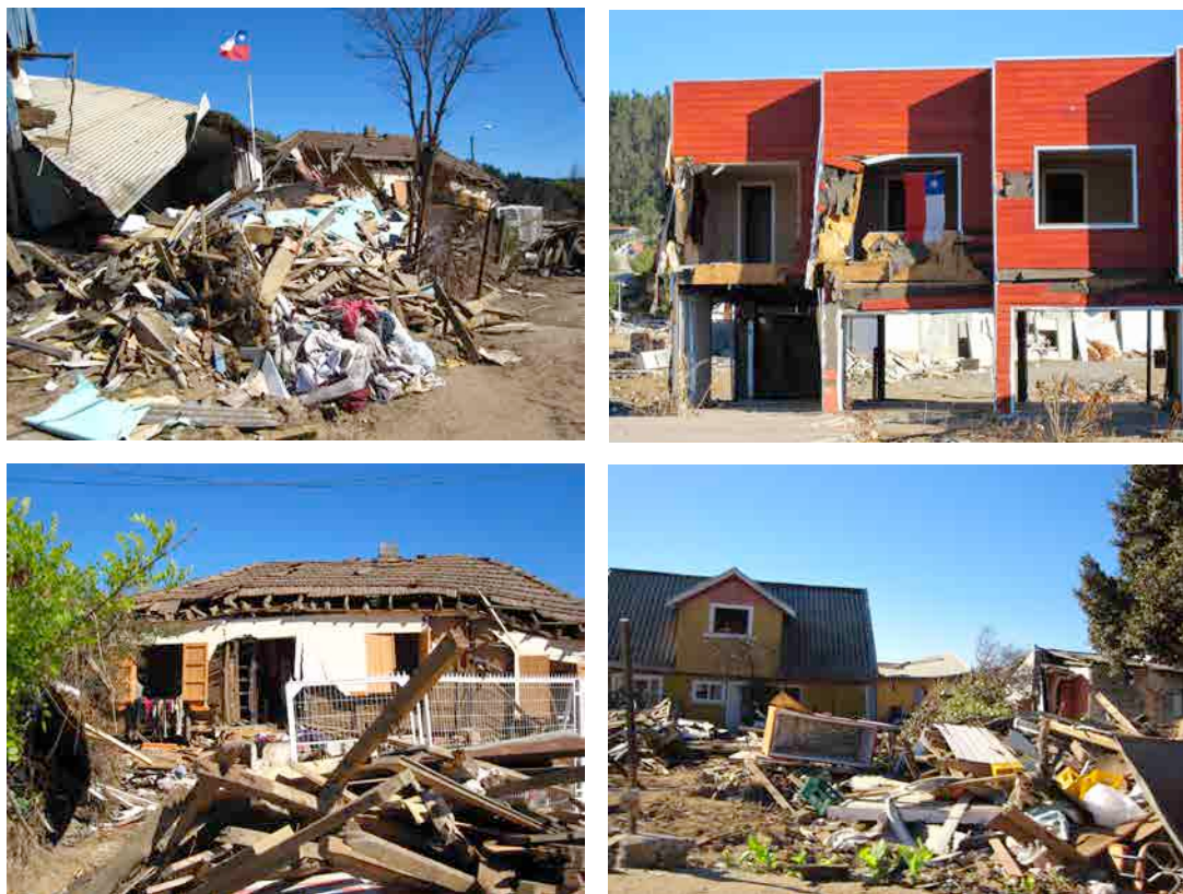
Figura 6.77-6.80 Casas derrumbadas en Dichato - Fotos propias del autor.
