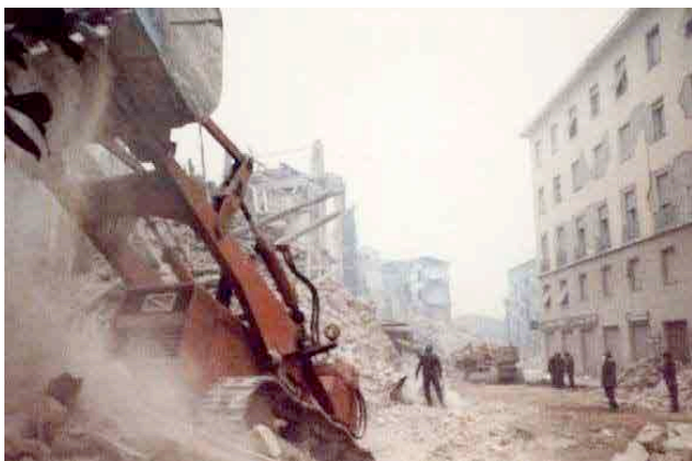
Figura 5.31 Excavadoras en el centro Iripino de Laviano, 1980.
