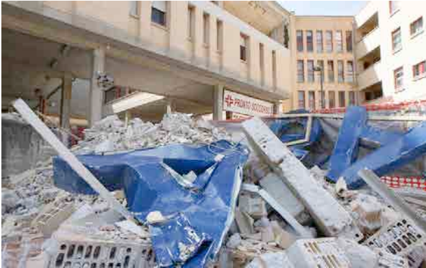
Figura 5.74 Hospital derrumbado tras el sismo. Aquila 2009.
