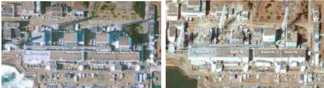
Figura 7.59-7.60 Gli impianti di Fukushima Daiichi prima e dopo lo tsunami
