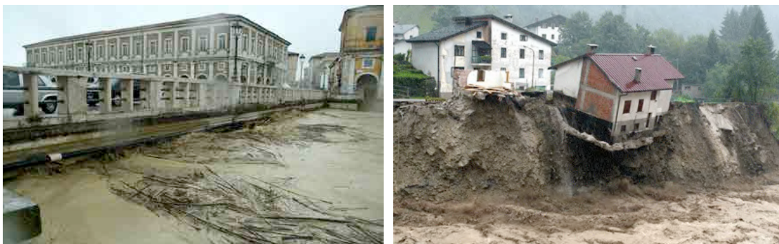
Figura 4.1-4.2 Puente ostruido por troncos y escombros. Fuente: www.uninews24.it (izquierda). Casa construida al lado del río en sitio vulnerable, inundación Italia. Fuente: Italpress (derecha).
