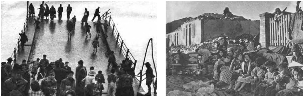
Figura 3.4-3.5 Puente sobre el Río Bío-Bío destruido (izquierda). Desolación en las calles de Concepción (derecha). Terremoto de 1960. Fuente: archivo fotográfico Sr. Alejandro Mihovilovic, Biblioteca Municipal de Concepción.
