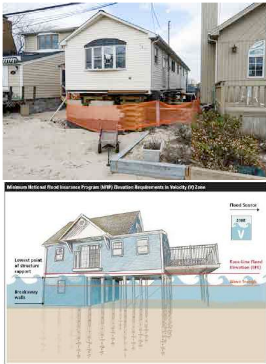
Figura 8.107 Breezy Point, N.Y., 22 de marzo de 2013 – Los residentes de este barrio en Queens están reconstruyendo los hogares que fueron destrozados por el huracán Sandy. Esta vivienda está siendo elevada al nuevo nivel de inundación para prevenir daños en futuras inundaciones.
