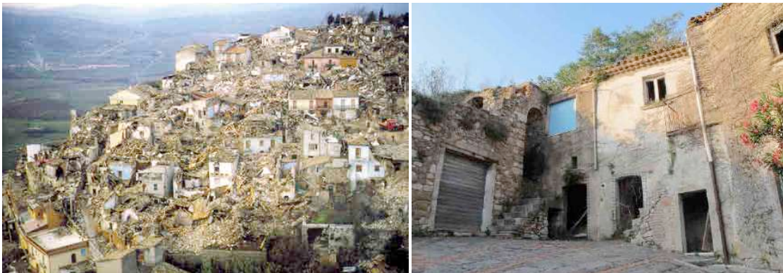
Figura 5.44-5.45 Conza después del terremoto. Fuente: Raccontiviandanti
