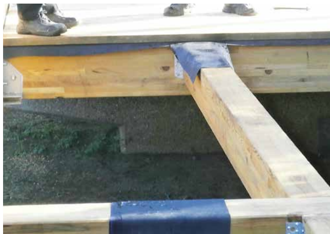
Figura 32. Ejecución del rediseño de la protección de vigas.
