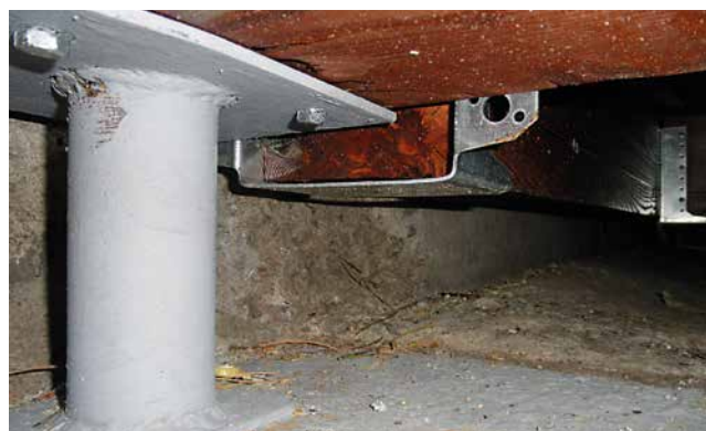
Figura 19. Ejecución del rediseño del contacto de jácena con el terreno.
