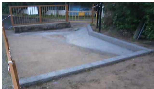
Figura 20. Separación del terreno, capa de mortero e inclinación para la evacuación del agua.
