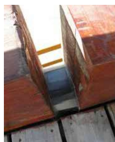
Figura 28. Ejecución del rediseño en apoyos intermedios.
