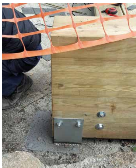
Figura 17. Ejecución del rediseño del contacto de jácena con el terreno.
