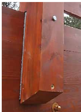
Figura 35. Ejecución del rediseño de apoyo de los montantes en jácenas.
