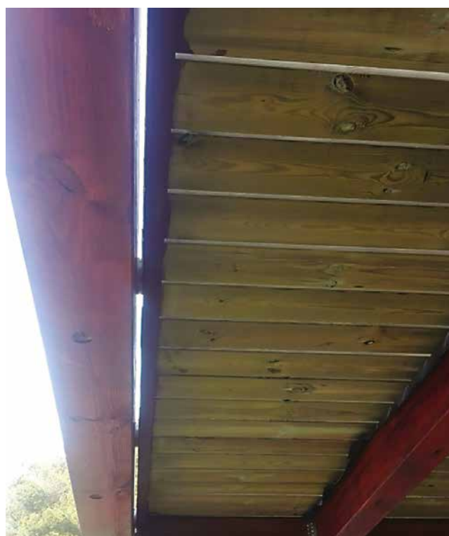
Figura 15. Ejecución del rediseño del contacto de vigas con jácenas.
