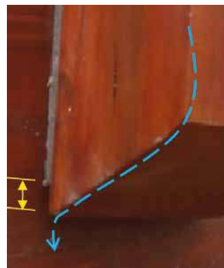
Figura 36. Formación del goterón.
