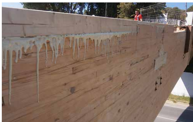
Figura 37. Injertos de secciones de la jácena.
