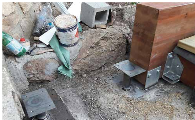
Figura 17. Ejecución del rediseño del contacto de jácena con el terreno.
