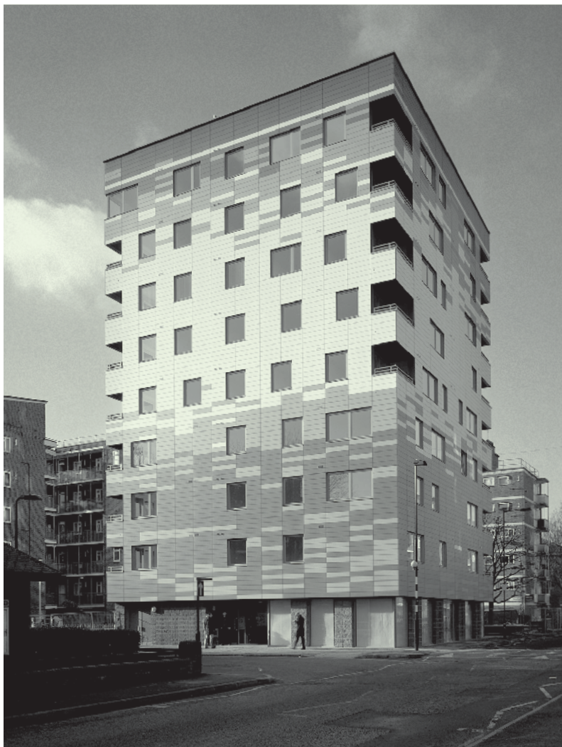
SLIKA 2 Drvena devetospratnica u Londonu izgrađena 2009. Izvor: Techniker.
