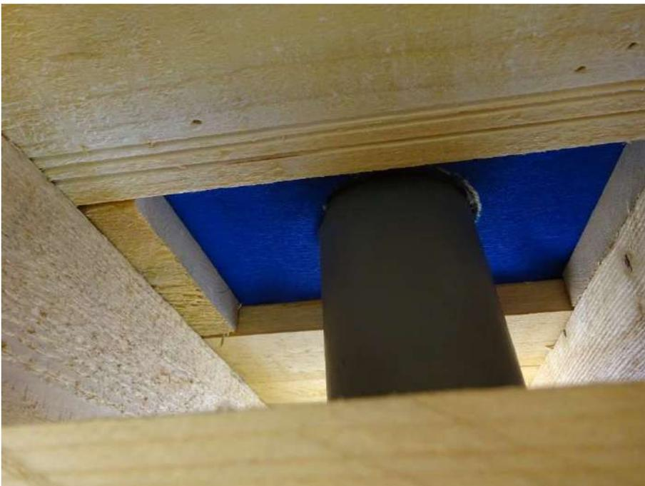
Abb. 10: Rohrdurchdringung von unten mit abgenommenem Revisionsrahmen zum Monitoring
