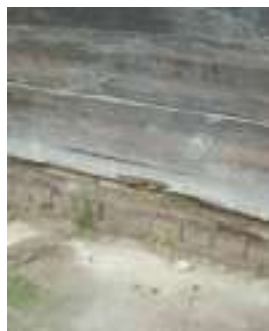
Truljenje podseka u dodiru s vlažnim temeljem
