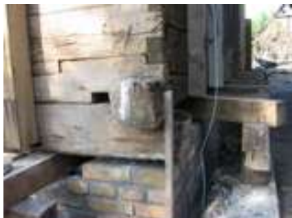
Podzidavanje nadtemelja ispod poduprtih podseka
