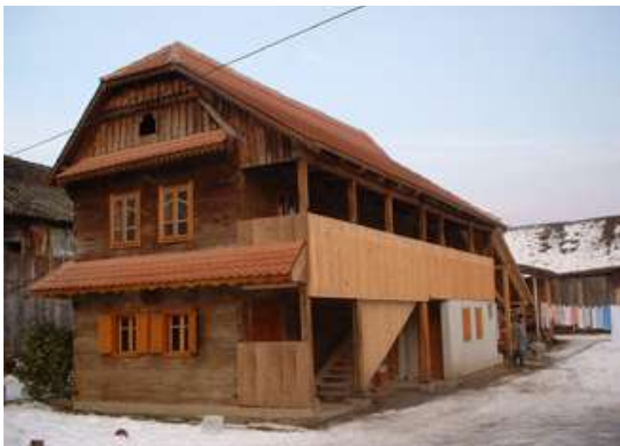
Obnova kuće u Čigoču br. 57
