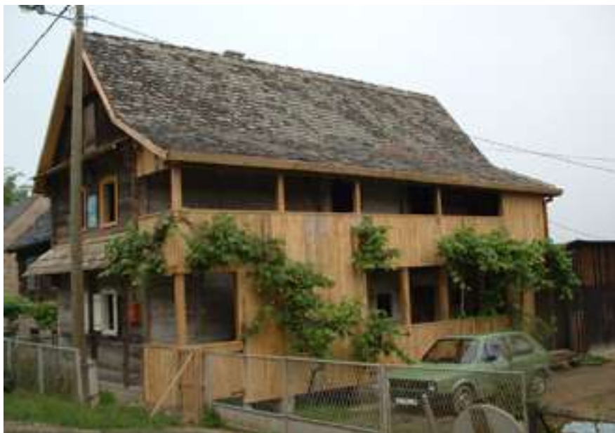
Obnova kuće u Krapju br. 164
