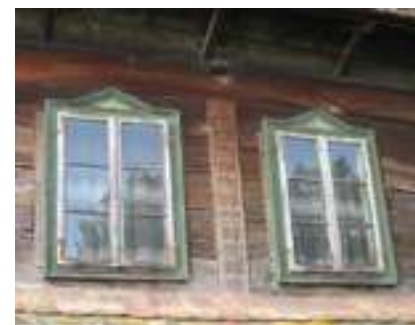
Postojeći prozori na glavnom (uličnom) pročelju kuće
