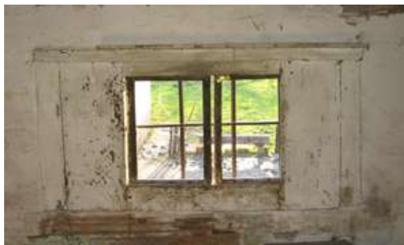
Tradicijski klizni prozor (krila se uvlače u šuplinu između stijenke od planjke i daščanog opšava)
