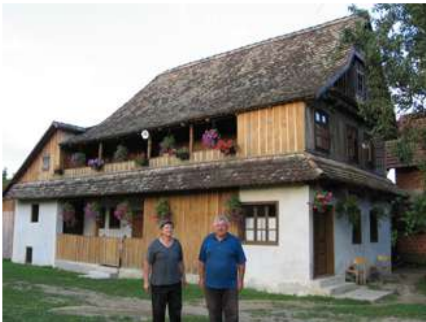
Obnova kuće u Lonji br. 1
