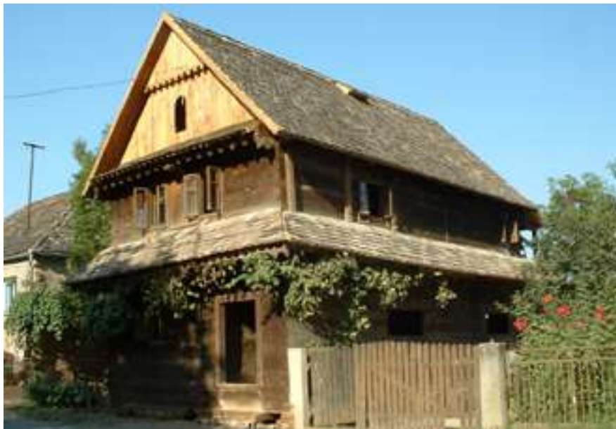
Obnova kuće u Krapju br. 30
