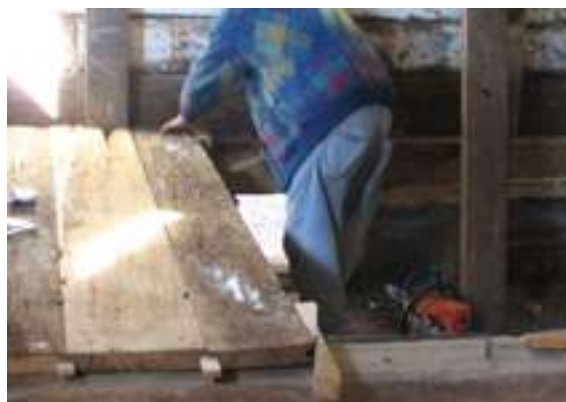
Rekonstrukcija poda prizemlja od planjki
