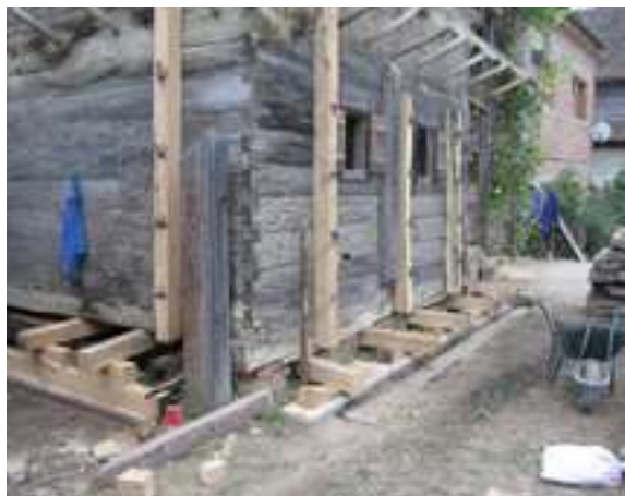
Sanacija temelja s niveliranjem kuće
