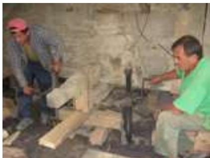
Podizanje stijenke kuće vintama (autodizalicom) pri niveliranju
