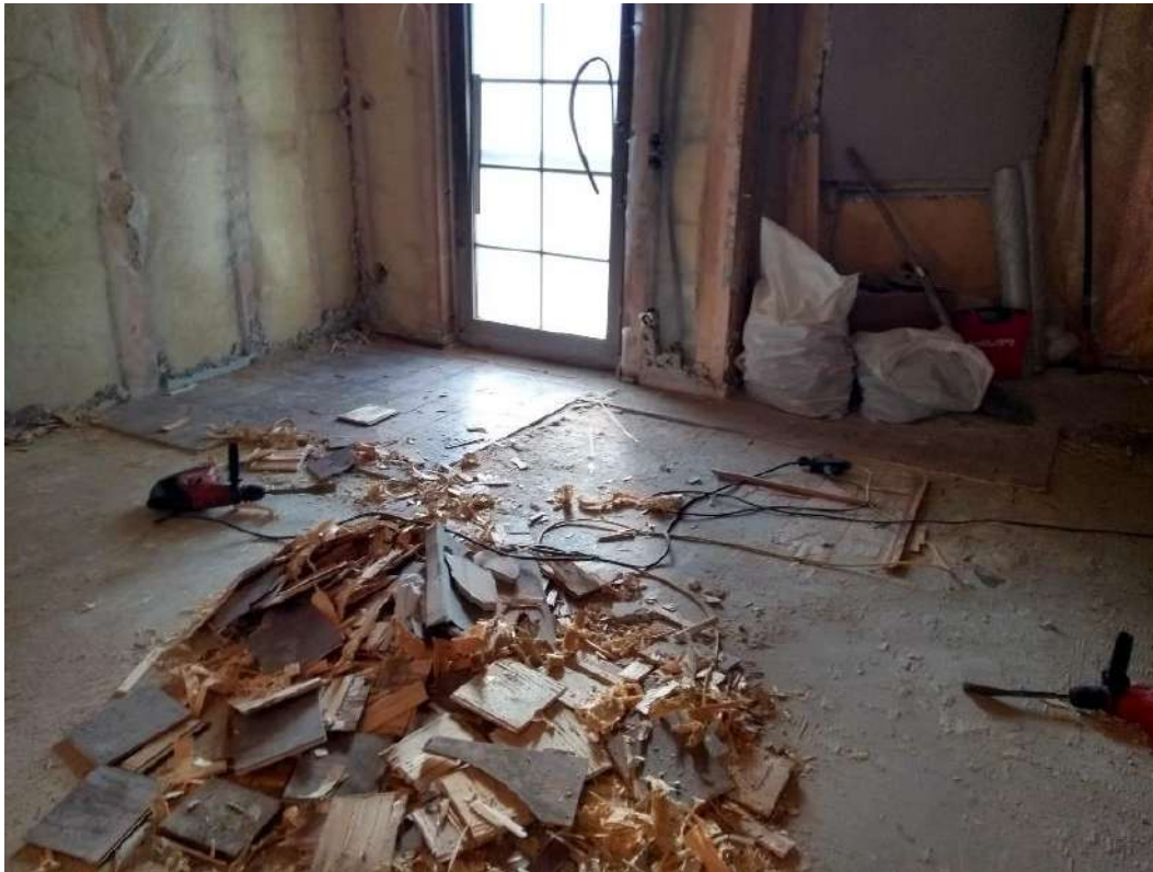
Abbildung 6: Entfernen des Fußbodenaufbaus
