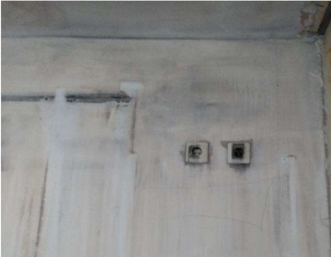
Abbildung 7: Oberflächliche Reinigung durch Handwischverfahren von Gipsplatten, nach der ersten Reinigung
