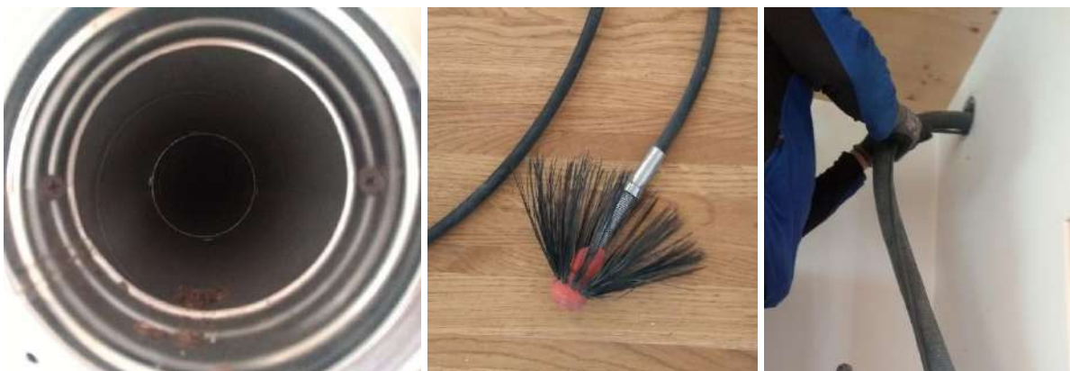
Abbildung 9: Mit Ruß beaufschlagte Lüftungsrohre werden mittels Rohrbürstenanlage gereinigt
