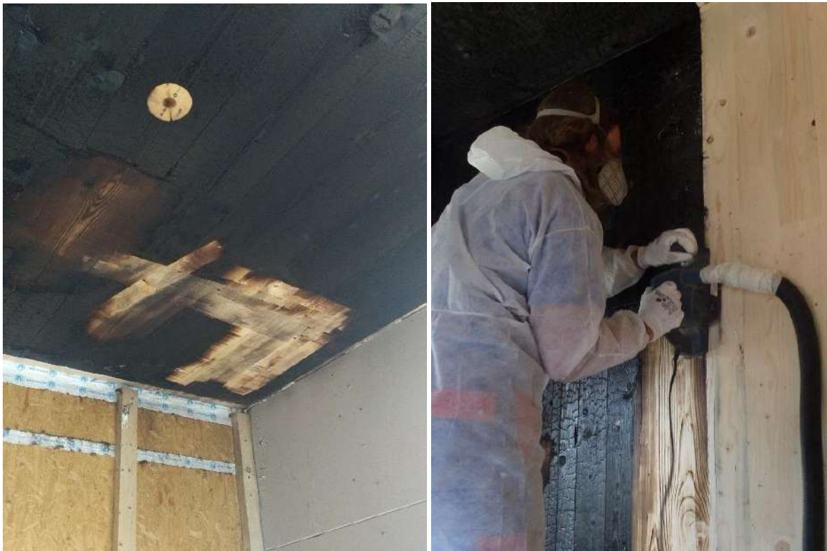
Abbildung 10: Sanierung der Holzoberfläche mittels Hobeln und Schleifen
